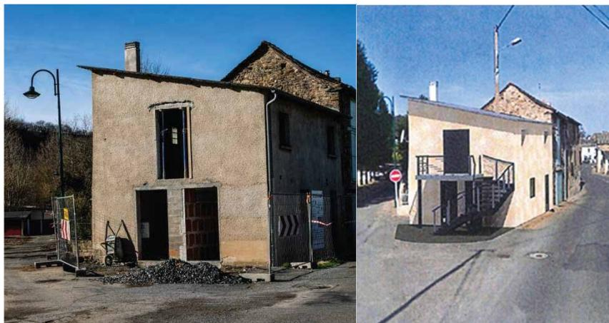
Le chantier est en bonne voie d'avancement ; les deux dalles ont été réalisées et les cloisons sont en cours. Une fois la rénovation terminée, les deux vestiaires se trouveront au rez-de-chaussée. À l'étage, dont l'accès se fera par un escalier extérieur, se trouveront le vestiaire de l'arbitre avec un WC, le bureau et le local technique.
