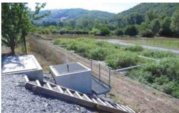
La station d'épuration par filtres plantés de roseaux d'une capacité de **750 équivalents habitants** fait l'objet de visites de suivi réalisées par le Service d'Assistance Technique aux Exploitants de Stations d'Épuration (S.A.T.E.S.E) du Conseil Départemental. Des bilans de fonctionnement sur 24 heures qui permettent de vérifier les performances épuratoires de l'installation ont été établis conformément à la réglementation en vigueur.
